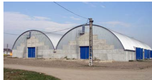
Vista di due silo affiancati
