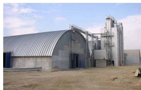
Impianto di stoccaggio di grande capacità con essiccazione
