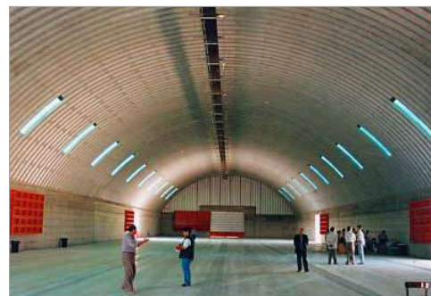
Vista interna di un silo
