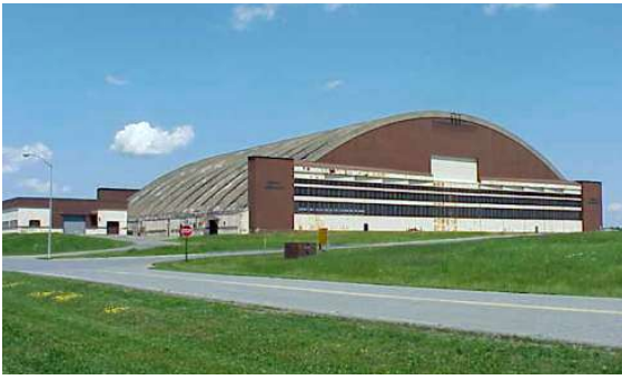
Hangar coperto con archi autoportanti
