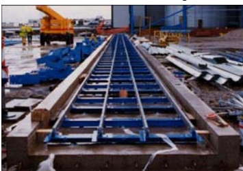
Guide e motoriduttore del portone ad ante scorrevoli
