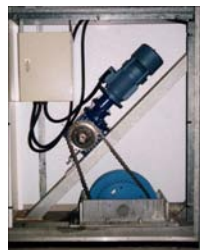
Guide e motoriduttore del portone ad ante scorrevoli
