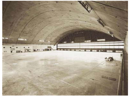
Vista piu ampia dello stesso hangar
