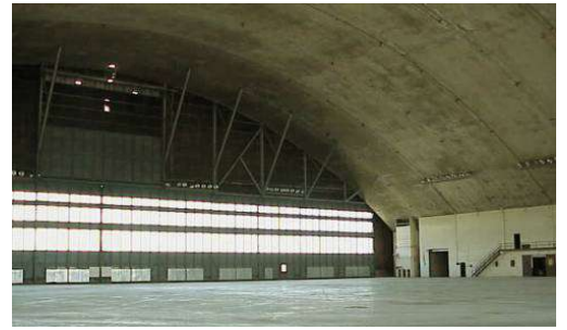
Vista interna di un hangar coibentato
