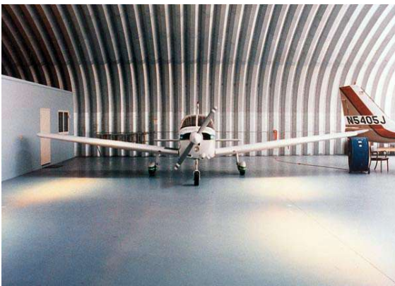
Vista interna di un hangar con archi policentrici
