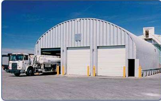
Magazzino con archi policentrici
