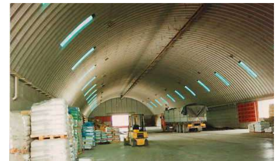
Magazzino con lucernai in fibra di vetro
