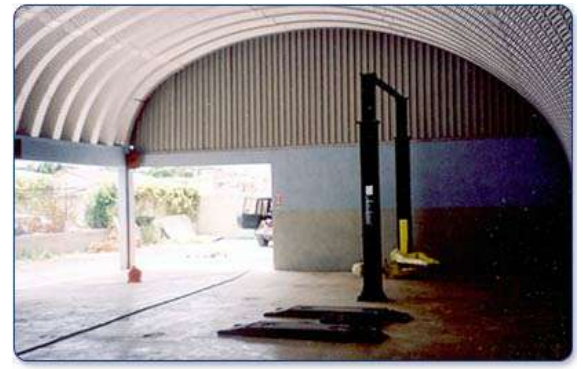
Piccolo fabbricato originale realizzato con archi policentrici
