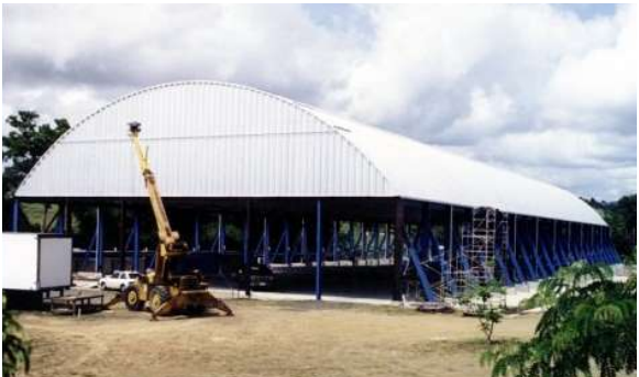
Tettoia con archi su struttura in ferro formata con travi e pilastri
