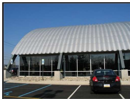
Maneggio coperto con struttura chiusa, con vetrate in policarbonato alveolare
