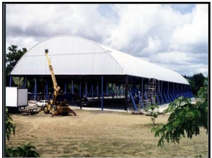
Copertura di un maneggio con archi su struttura in ferro
