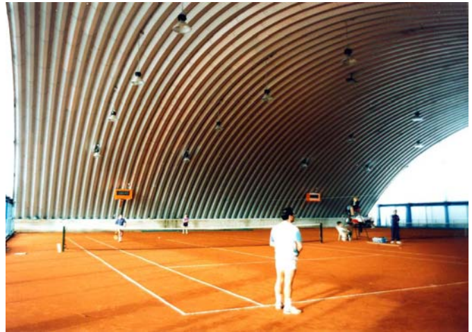
Copertura di due campi da tennis
