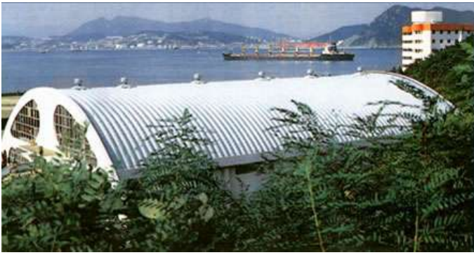
Vista esterna di un fabbricato polivalente
