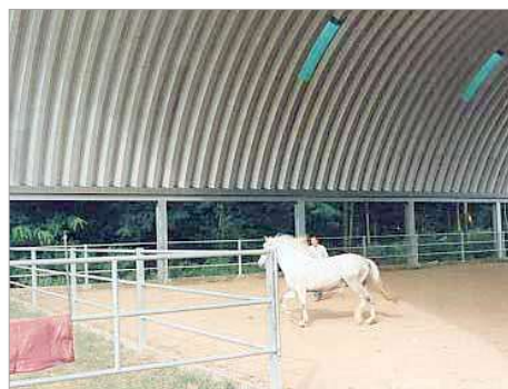
Particolare di una copertura maneggio con lucernai in fibra di vetro
