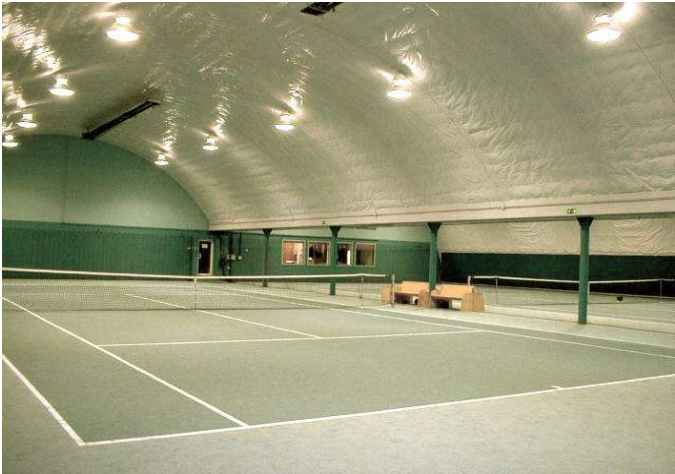
Vista interna di copertura coibentata di campi da tennis
