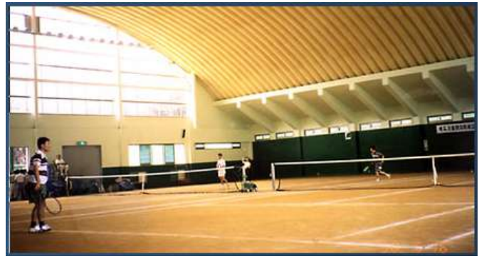
Vista interna di copertura coibentata di campi da tennis
