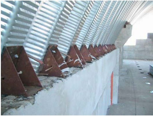
Banchina di connessione archi con il muro
